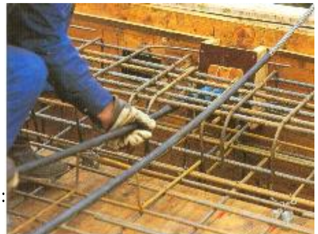
Einbau des Spannankers zwischen der schlaffen Bew.
