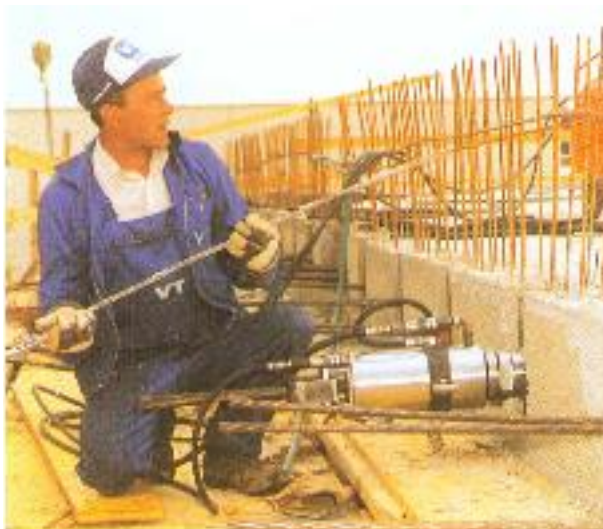
Mit einer Presse werden die Spannkabel gespannt
